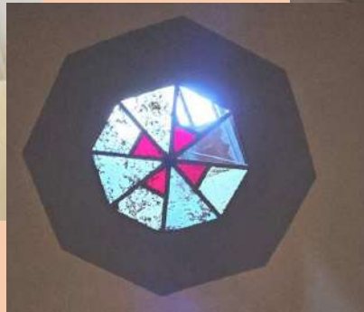
Rottura delle vetrate del lucernario nella Cappella del Santissimo Sacramento
