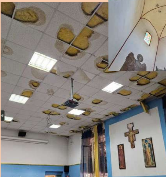
Controsoffitto Aula S. Chiara
