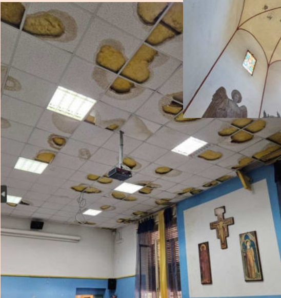
Controsoffitto Aula S. Chiara
